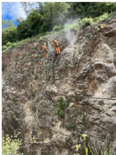
Travaux de sécurisation de la paroi rocheuse de Pétafi
