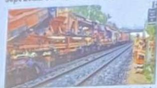
Reprise partielle de la géométrie du talus au droit du franchissement de l'Ambène et dégarnissage partiel du remblai (afin d'en réduire le poids et d'accroître sa stabilité).
